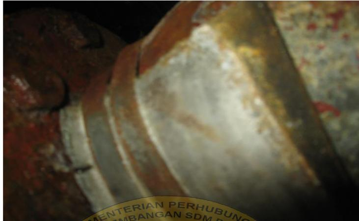
Gambar 2.22 Penambalan Pipa menggunakan *rubber*
