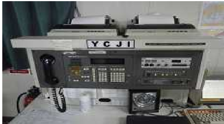
Gambar 4.1 : GMDSS yang tidak dapat digunakan
