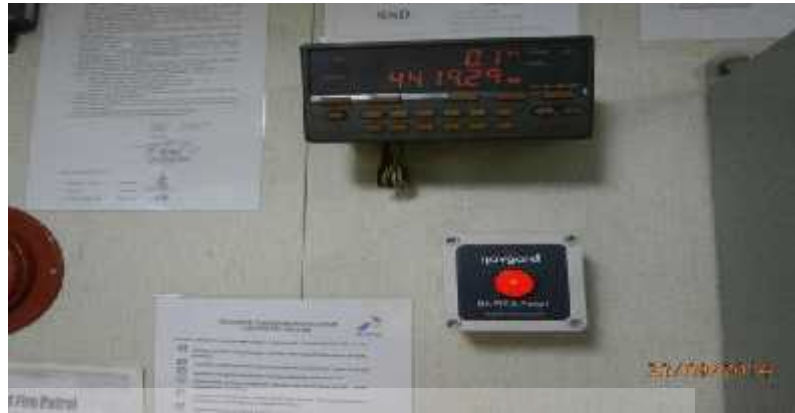
Gambar 4.3 : Speed Log yang rusak di atas kapal MT.Pegaden.
