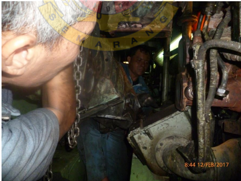
Gambar. Proses pemasangan turbocharger pada mesin diesel generator
