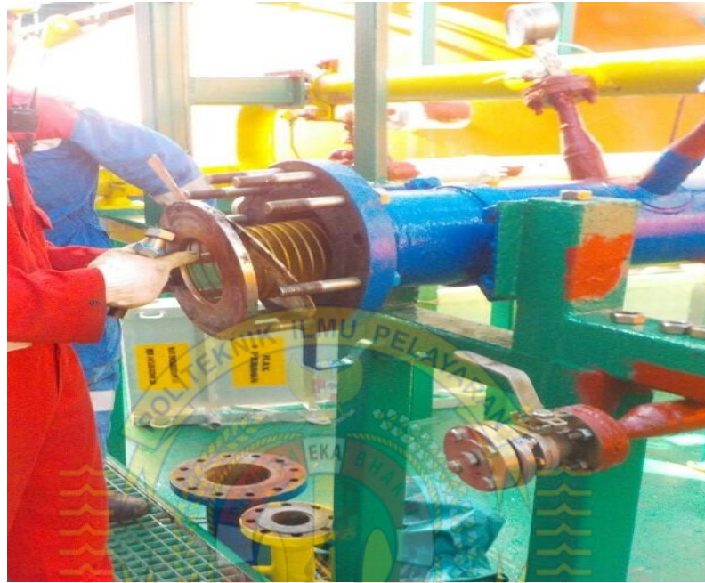
Gambar 5.2 Pemasangan Manifold Filter Kapal Gas Arar
