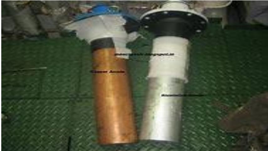
**Gambar spare katoda dan anoda bari yang siap dipasang**
